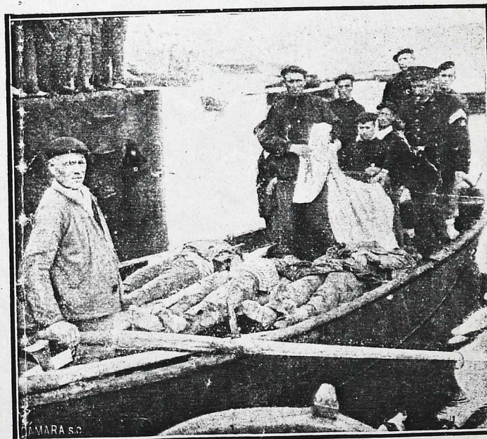
Tres de los cadáveres de los naufragos que fueron encontrados en las costas francesas, cerca de las peñas denominadas "las gemelas"
