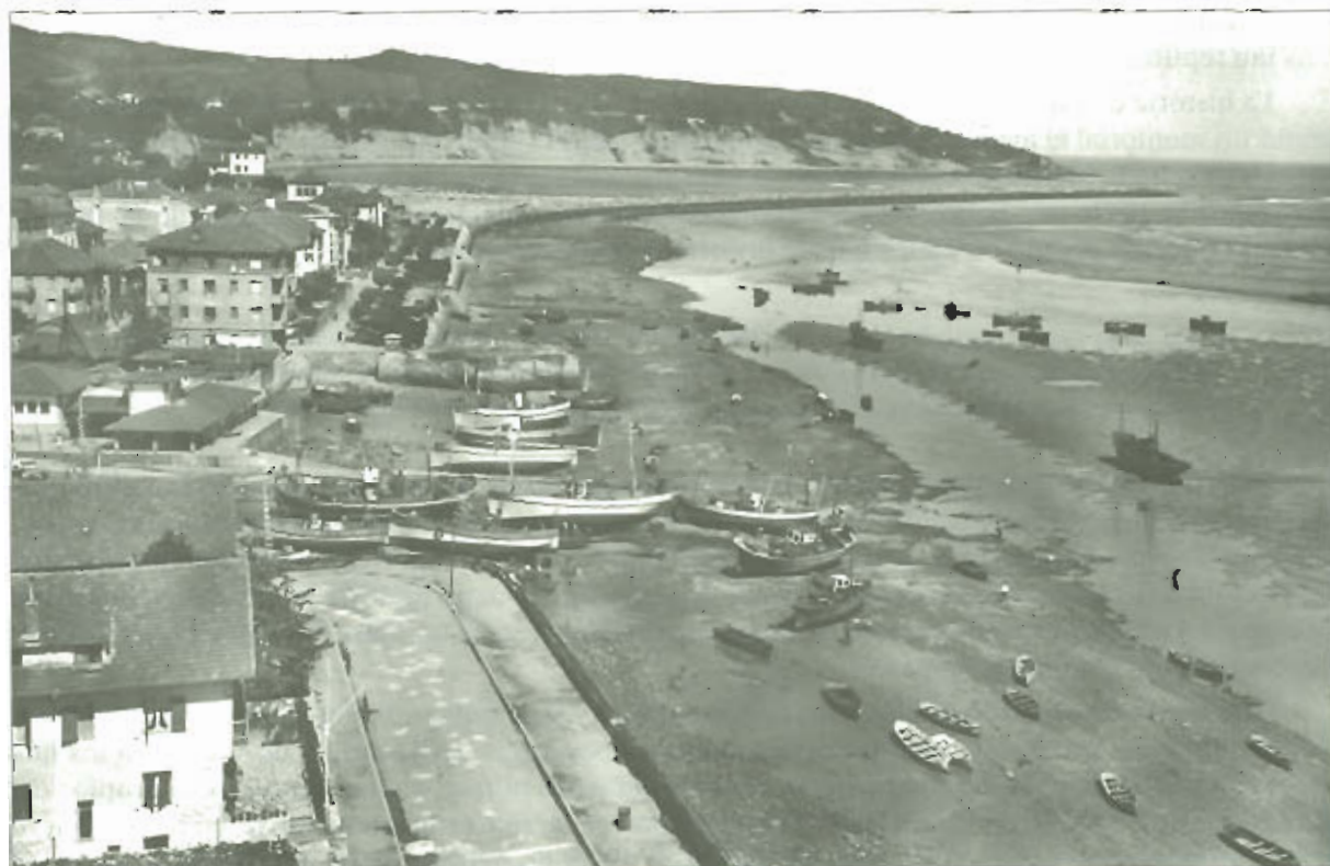
Ilus. 39. Barcas varados en la arena en las inmediaciones de la rampa de la Lonja y el Astillero Aseguinolaza durante la bajamar. Archivo Municipal de Hondarribia, Fondo fotográfico nº 492
