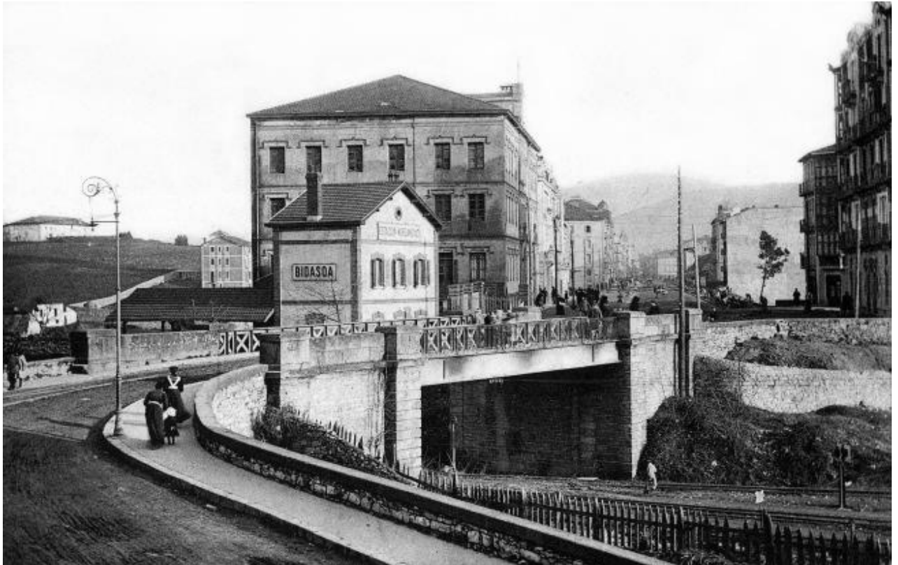
Irún, al comienzo del Paseo Colón, puente sobre vías del tren
