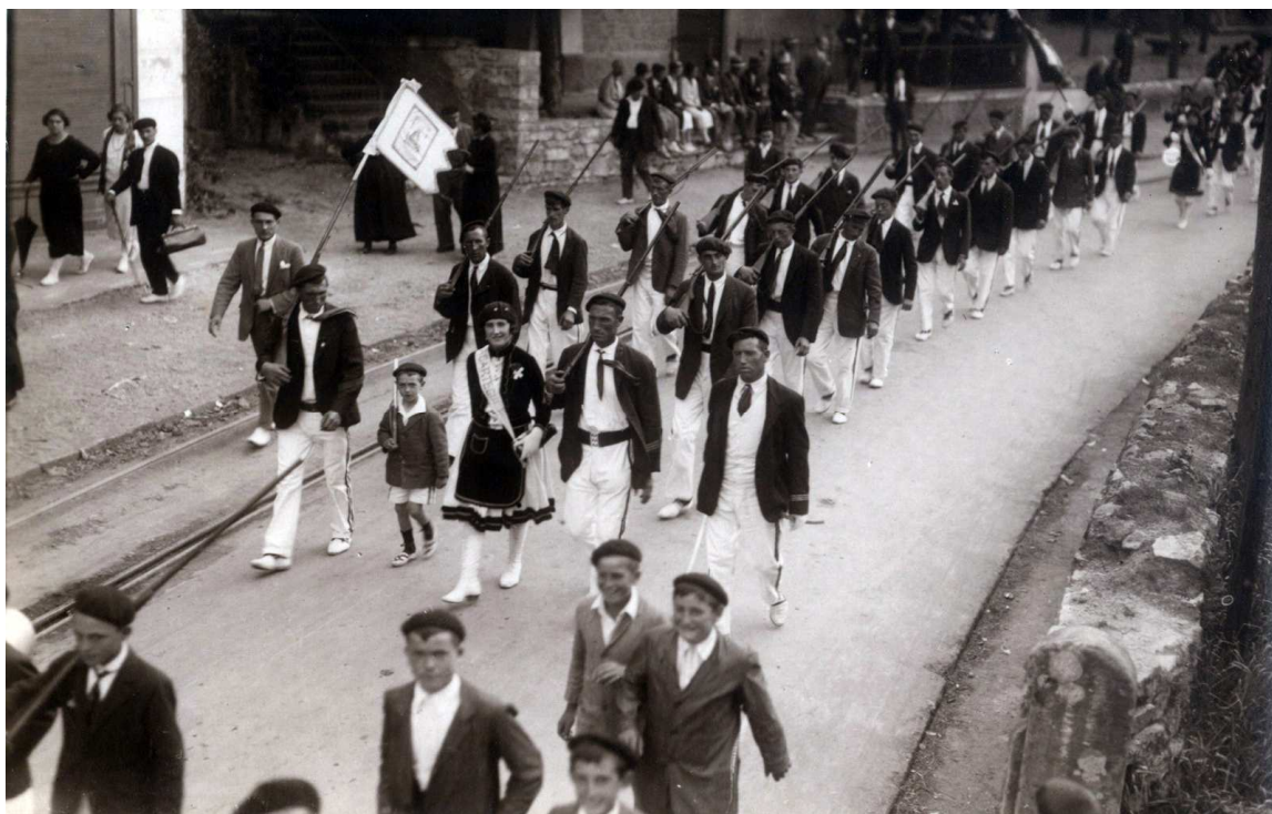
Vías del Tranvía, en C/ Extramuros, junto al edificio de la Diputación Foral.
