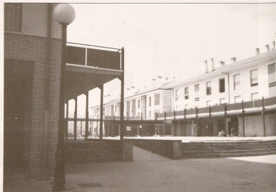
Puntalean eta Zezen Plazan daude 25 etxebizitza berriak.
