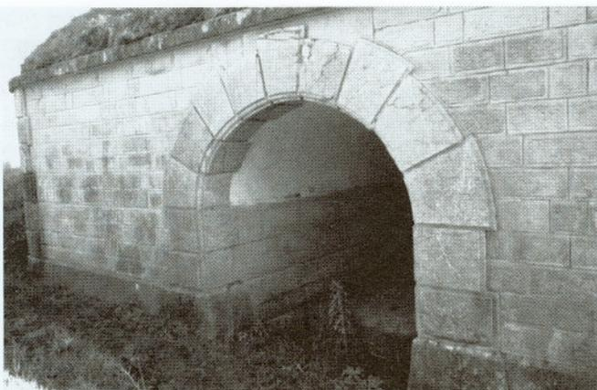
Obra del Centro. Acceso a la bóveda para abrigo y guarda de piezas de artillería incorporada en el través oriental.
