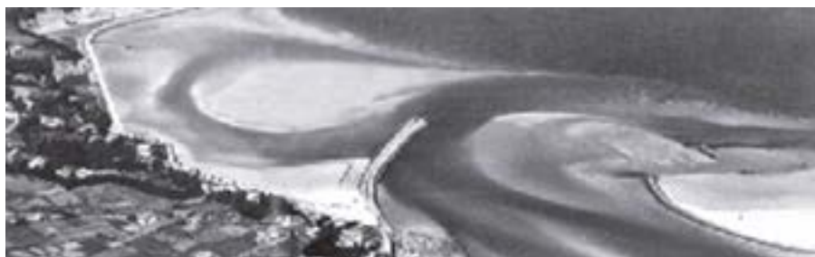
Fuga del canal en 1951.
