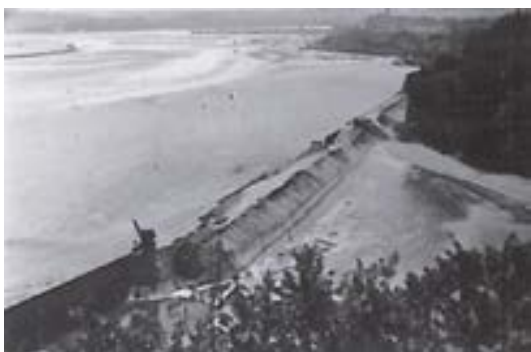
La gran playa discurriendo junto al muro en construcción de la carretera al puerto refugio.
